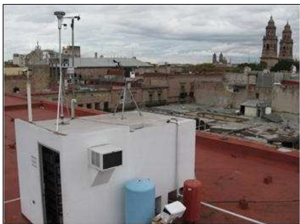
Figura 1. Caseta de monitoreo atmosférico, ubicada en la terraza de Palacio Municipal en el Centro de la Ciudad de Morelia.
